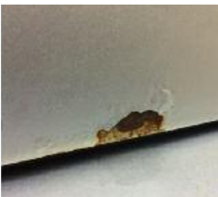
Lackskador som medfört rostangrepp.
